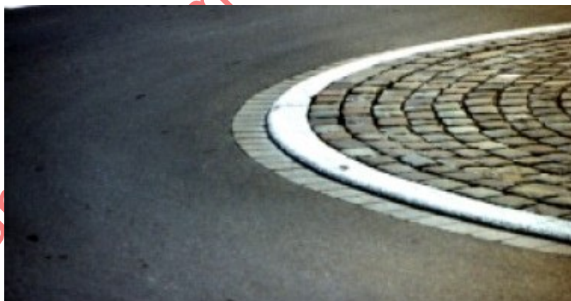
43. ábra – Példa az épített középsziget kialakítására mini körforgalom esetén
