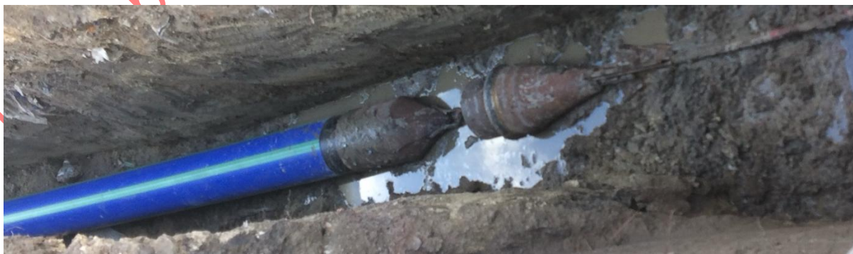
5.46. ábra – Csőroppantás, az új haszoncső behúzása
